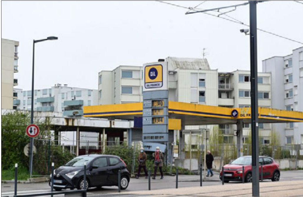
Les travaux de déconstruction de l'ancienne station-service ont commencé à Planoise.
