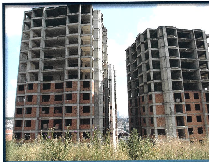
Photo ci-dessus : En périphérie ouest de la municipalité du grand Istanbul, Esenyurt est l'un des arrondissements les plus peuplés, avec près d'un million d'habitants. Ici, en mai 2023, un chantier de construction à l'arrêt montre le ralentissement économique dans ce secteur pourtant très dynamique. (© Yoann Morvan, mai 2023)
